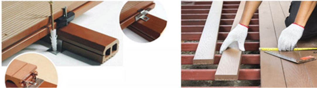
شکل ۶- استفاده از قوطی آهن و پروفیل چوب پلاست در زیرسازی
