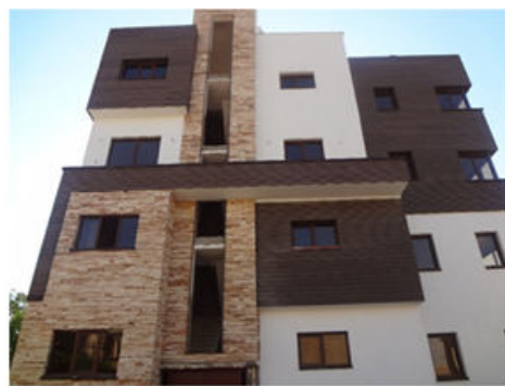
شکل ۱۵- اجرای ترکیبی چوب پلاست و سنگ
